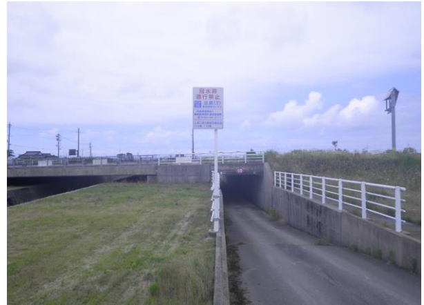
山側から海側を望む
