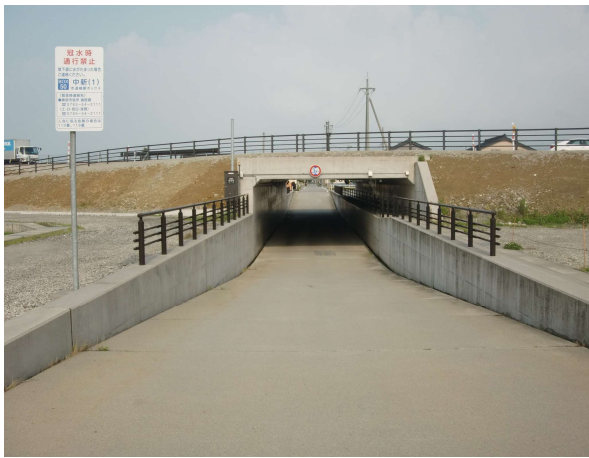
海側から山側を望む
