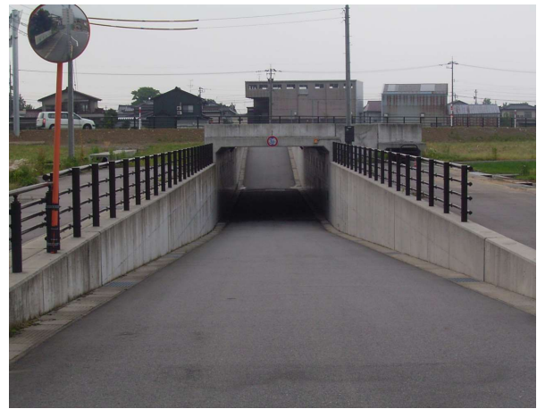
山側から海側を望む
