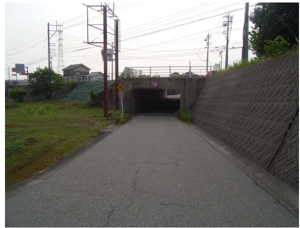
山側から海側を望む
