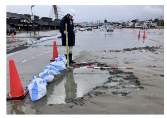
ひみ番屋街駐車場の液状化
