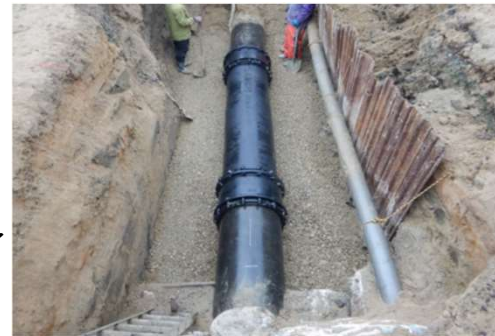
農業用水パイプラインの復旧
