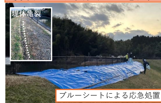
農業用ため池災状況と応急処置
