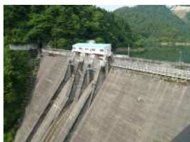
堤体・洪水吐き
