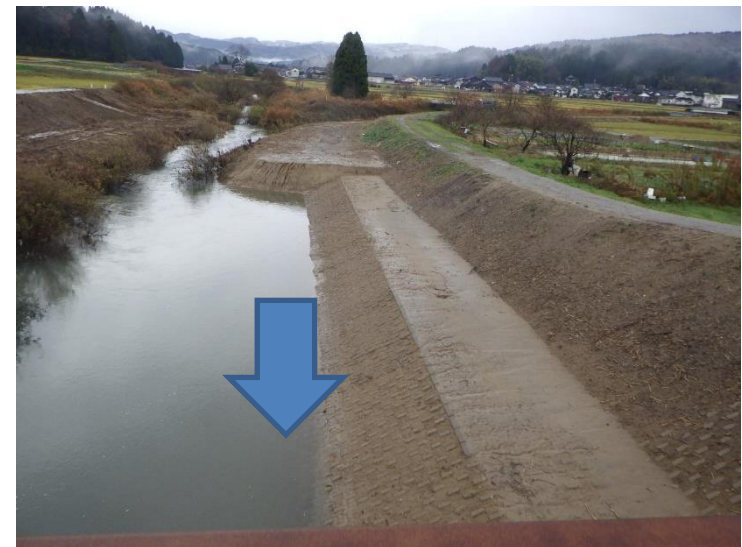
河道浚渫実施後(上庄川)
