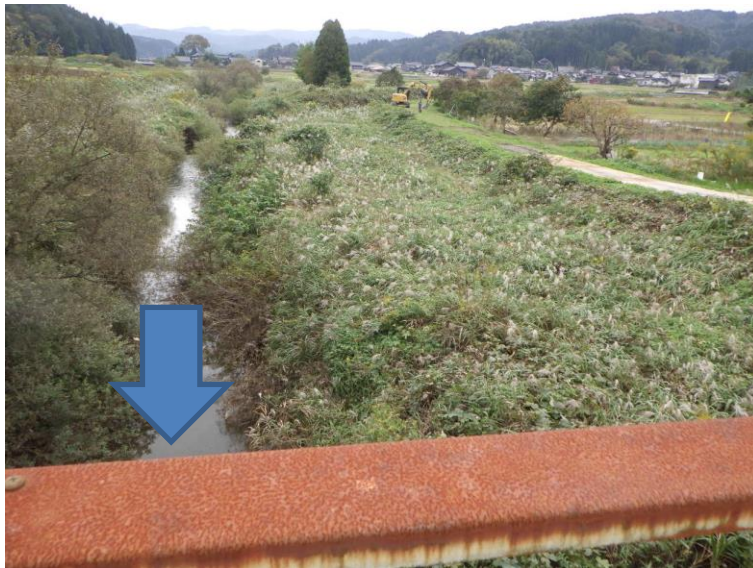
河道浚渫実施前(上庄川)
