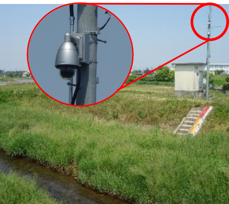
河川監視カメラ設置状況
