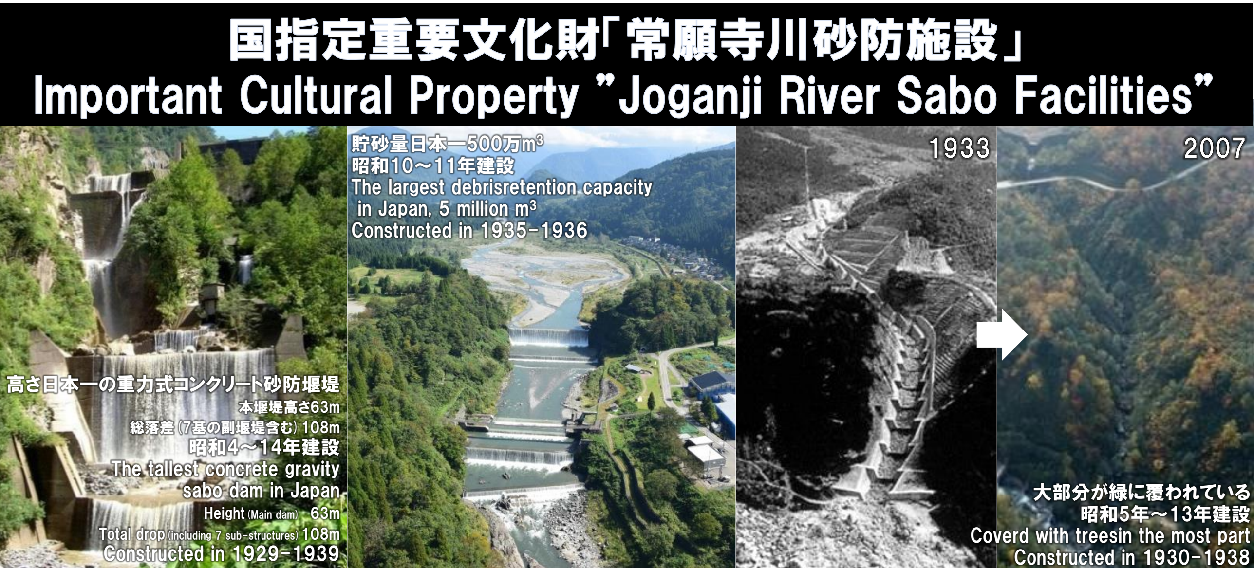
写真-1 白岩砂防堰堤 Photo 1 Shiraiwa Sabo Dam
