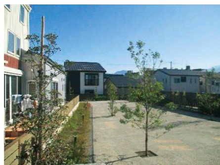
防災広場整備
