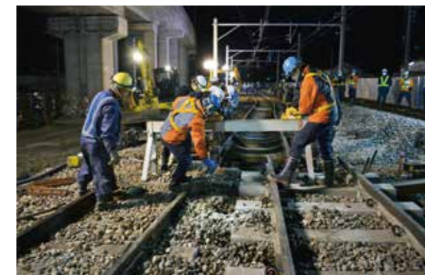
深夜の線路切替（R4.12.3～4）
