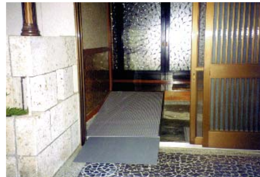
▲玄関戸をはさんだスロープ
