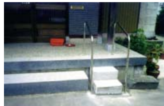
▲ポーチの段の横に手すりのついたゆるやかな段の設置
