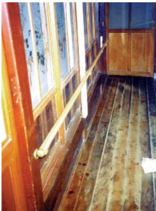
▲ 4枚引き戸の中間に補強柱を立てて、手摺を連続させる
