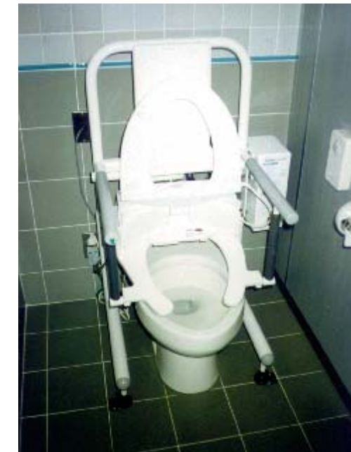
▲電動簡易昇降便座設置
