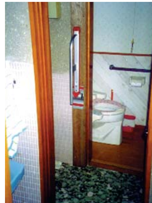
▲小便器前に上下式手摺を設置
