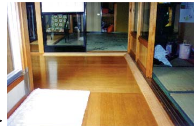
くさびの小口がひっかかるので、廊下全体に取付▶
