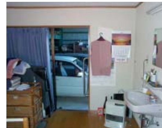
▲車庫に直接出入口を新設
