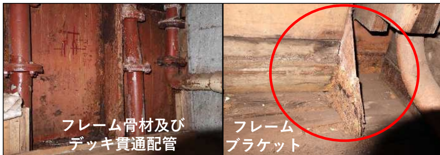
船体内部骨材補修
