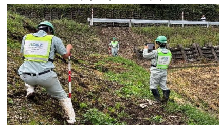
現地調査の様子(農地の崩落)
