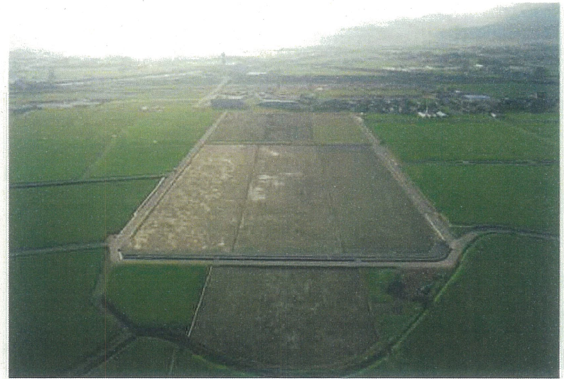
(有)河内組施工の「ほ場整備舟川新地区第9工区ほ場整備工事」
