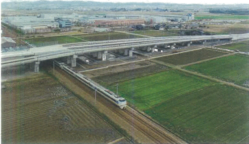
川田建設(株)北陸支店施工の「主要地方道小杉婦中線道路総合交付金針原跨線橋（仮称）上部工その2工事」
