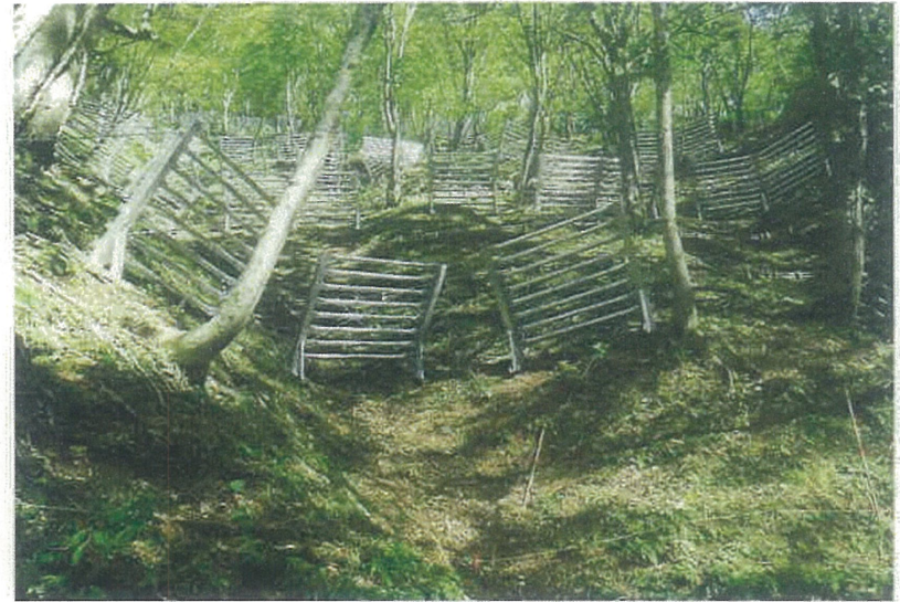
(株)羽馬施工の「環境防災林整備漆谷柵工事」
