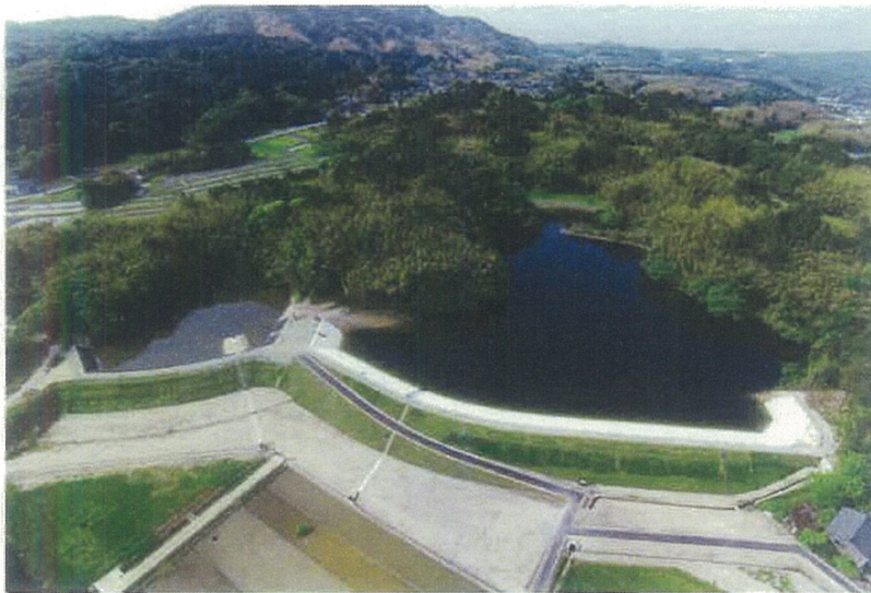
三久建設(株)施工の「ため池等整備鳥尾地区鳥尾大池堤体改修工事」
