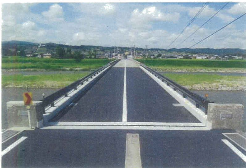
佐藤鉄工(株)施工の「主要地方道立山山田線橋梁災害復旧高善寺橋上部工工事」
