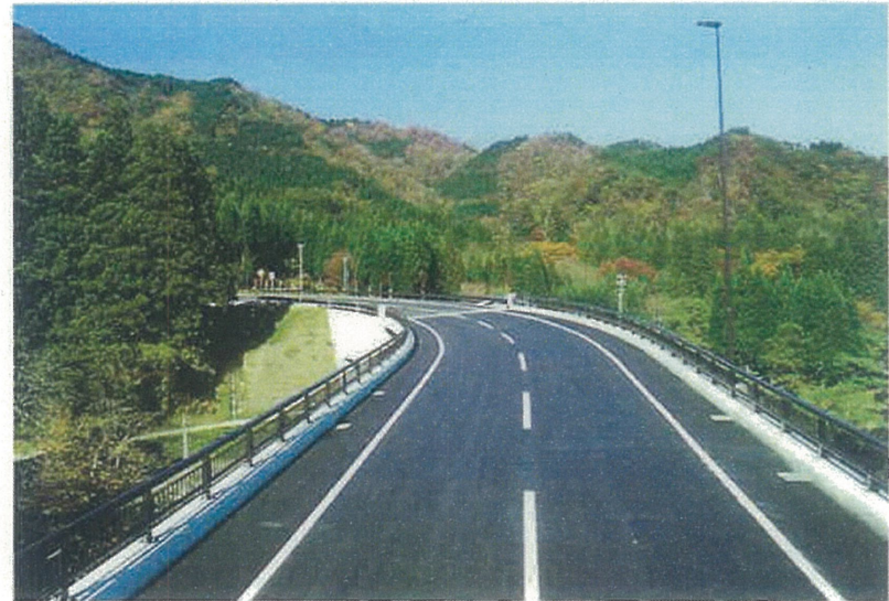
川田工業(株)施工の「一般国道471号道路総合交付金（改築・国道）栃折橋上部工工事」
