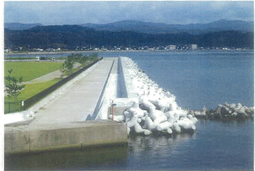
氷見土建工業(株)施工の「氷見漁港漁港機能強化護岸工その3工事」
