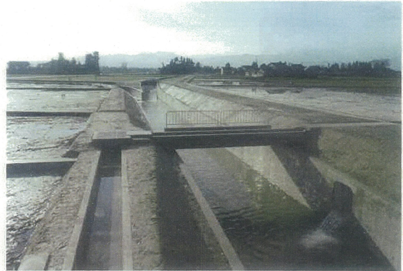
北陸ハイウェイ建設(株)施工の「農地防災庄川左岸二期地区苗加用水路第1工区工事」
