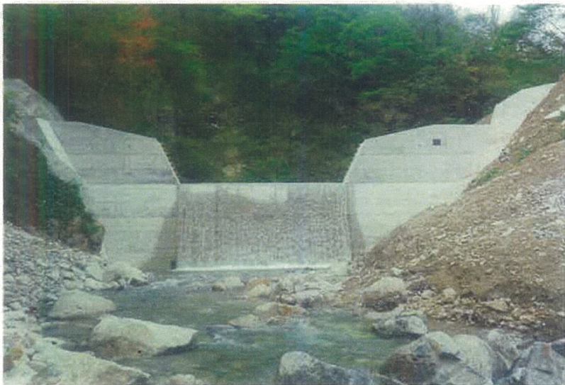
(有)慶治組施工の「復旧治山（切詰）溪間工事」
