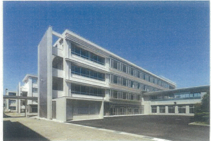
川田工業・江尻工業共同企業体施工の「富山県立高岡工芸高等学校建築電気土木棟新築工事」
