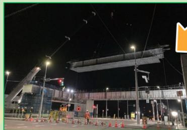
R5年:鋼桁の夜間架設(二塚交差点)
