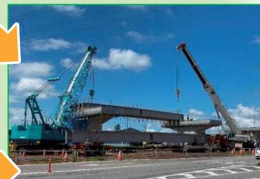
R5年:コンクリート桁の相吊架設
