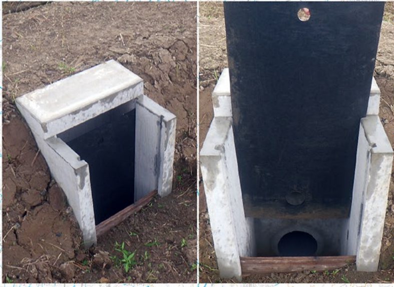
田んぼダム型排水槽の設置(オ川七1期地区 南砺市)
