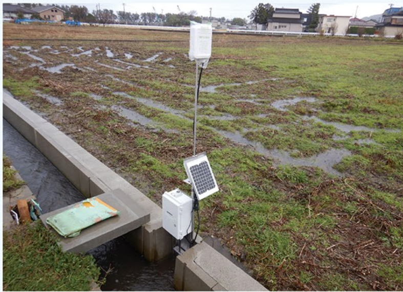
自動給水栓による水管理の省力化(五箇庄北部地区 朝日町)
