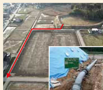
ため池を活用した農業用水の パイプライン化（中村地区 氷見市）
