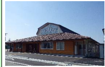
県産材を使った木造公共施設
