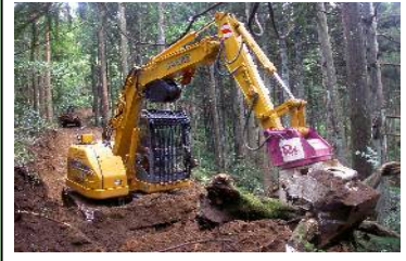
最新林業機械による作業道作設
