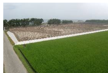
海岸保全対策の推進(入善海岸)
