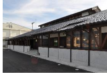
県産材を使った木造公共施設
