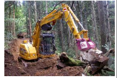
最新林業機械による作業道作設
