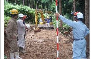
作業道ルートを選定実習
