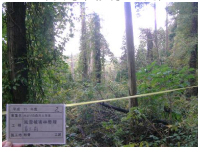
【風雪被害林整理】 (氷見市鞍骨 地内)
