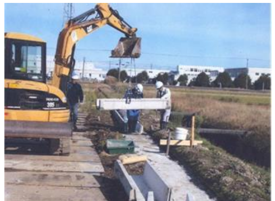
直営施工による水路改修
