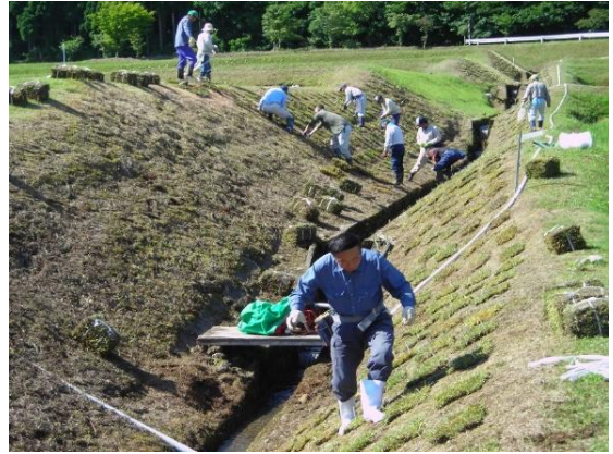
水路法面への芝の植栽
