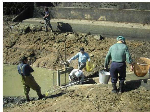
施設保全(ため池の水抜き):⑤射水市金山
