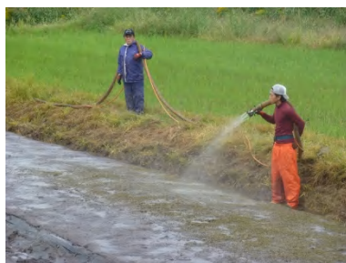
胞子吹き付け作業
