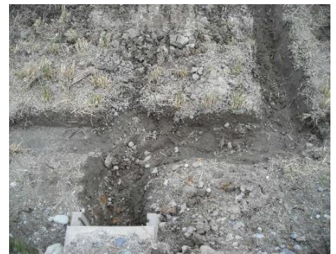
排水溝を排水口に必ず連結
