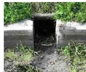
排水口は深く掘り下げ、 確実に連結
