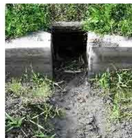
排水口は板を外し深く掘り下げ、確実に連結
