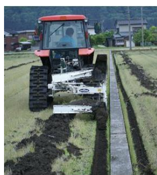
額縁排水溝の設置
