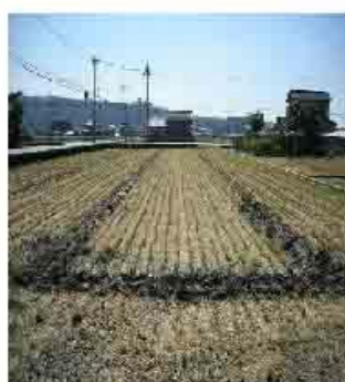
基幹排水溝の設置
