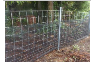
柵への目隠しネット設置
