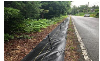
電気柵下へのアース機能付き防草シート設置
