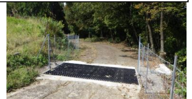
耐雪型柵と接続した 道路へのグレーチングの設置
