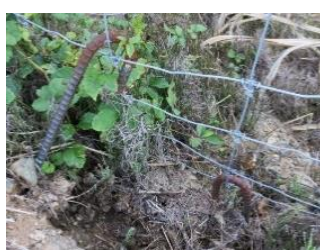
写真5 柵下部の補強事例
