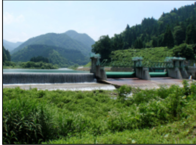
養輪頭首工 (右岸側下流より上流側を望む)
