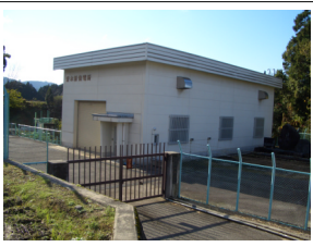
愛本新発電所
