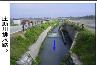
庄助川排水路
