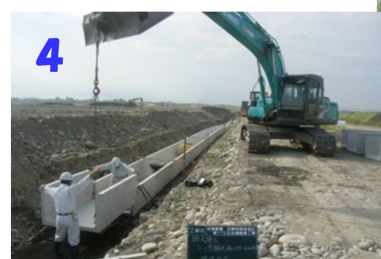
新しい水路や道路をつくります
