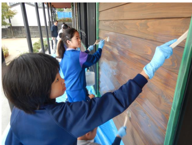
校舎外壁の塗装の様子
