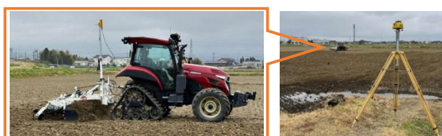
写真1 レーザーレベラーによる傾斜施工の様子
