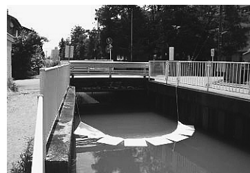
油吸着マットによる流出防止
