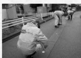
散水ノズルの点検
