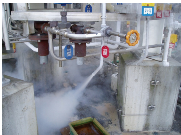
図 4 - 3 検液弁による確認状況
