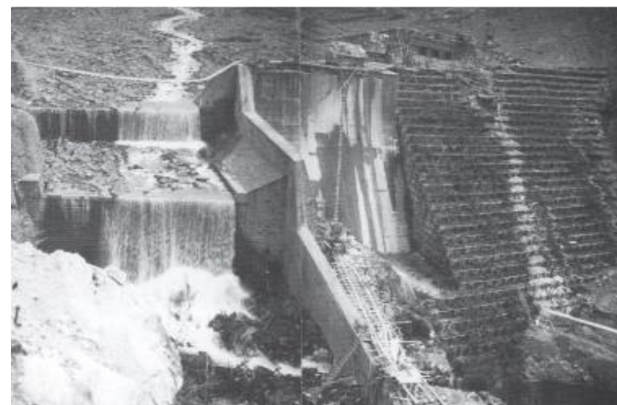
1939年（昭和14年）白岩砂防堰堤の竣工
