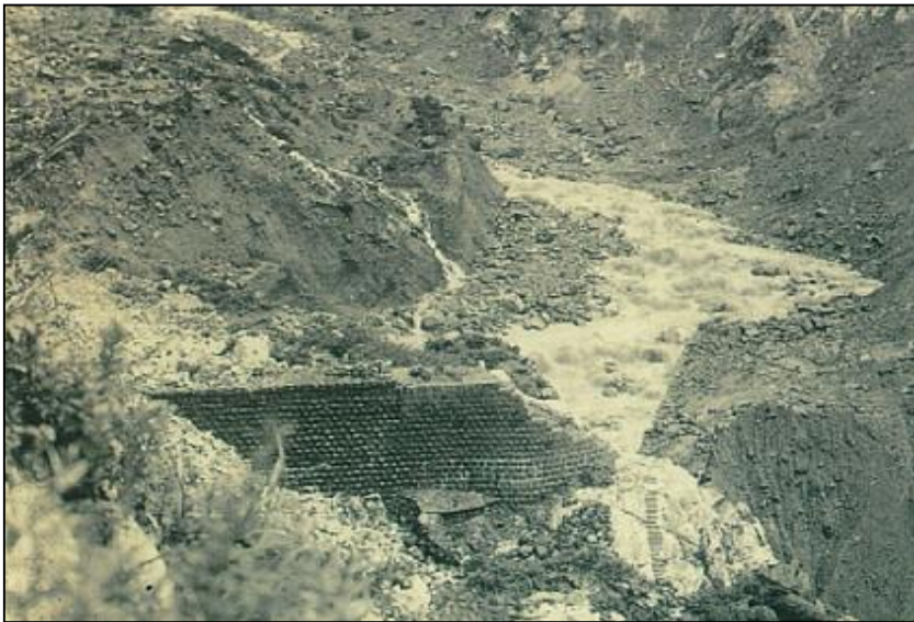
湯川第1号えん堤 被災後（大正11年）
