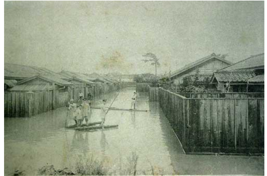
神通川の大水による浸水の様子
