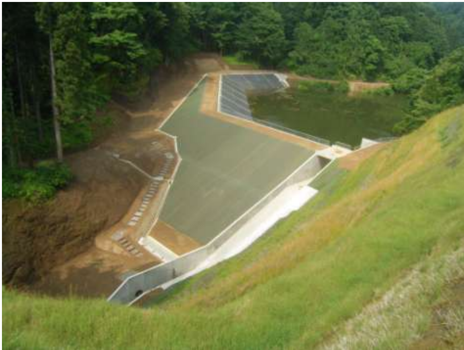
整備後の状況 (西勝寺地区:南砺市)
