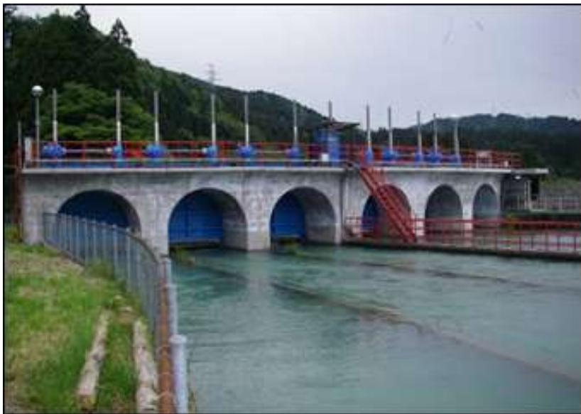
長寿命化対策した沈砂池・制水門 (黒部川合口地区:黒部市)
