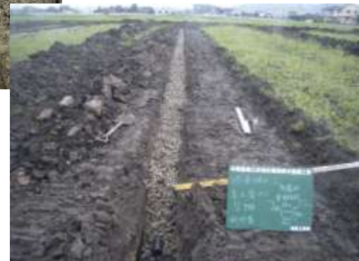
暗渠排水の施工により 汎用化される水田 (江尻地区:高岡市)
