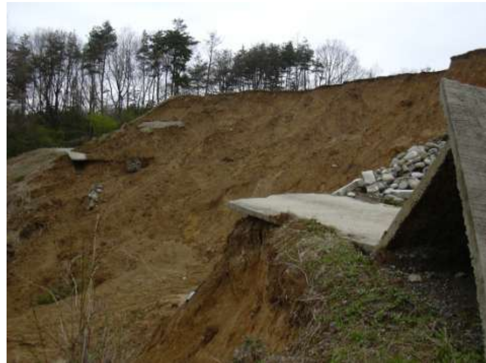
地すべりの状況 (中瀬第3地区:富山市)
