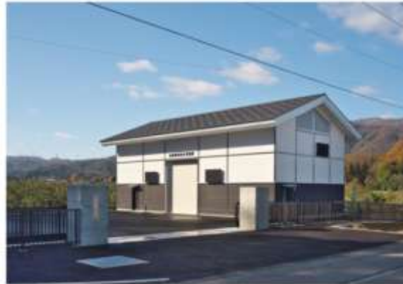
平成25年3月完成 山田新田用水発電所(南砺市)
