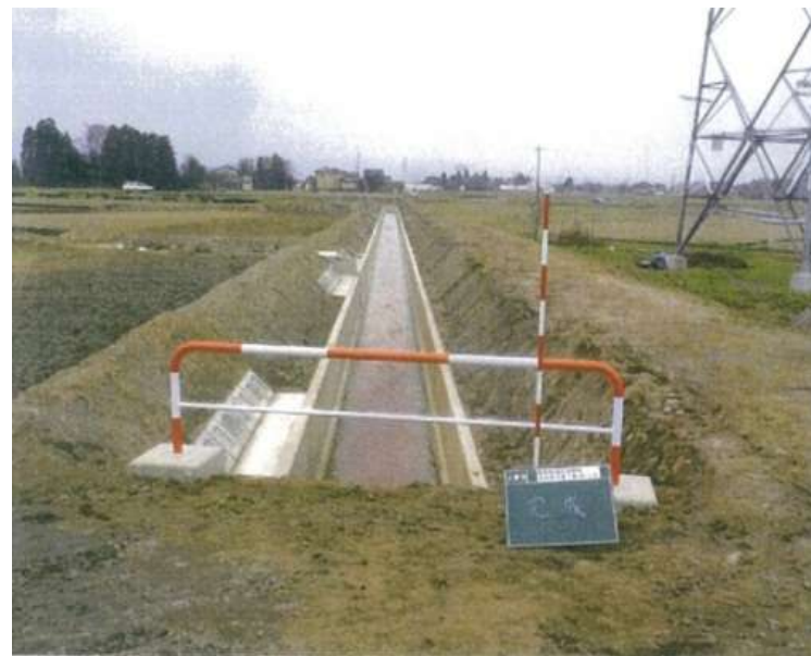
団体営かん排で整備した排水路 (水橋五郎丸地区:富山市)
