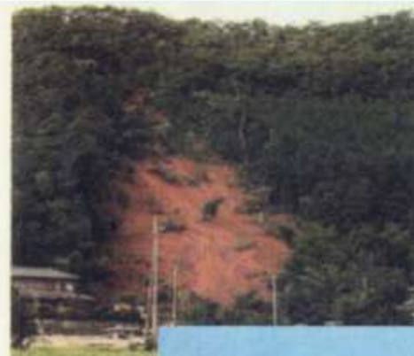
←豪雨により 森の斜面が崩壊
