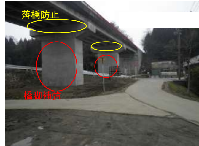
耐震対策を実施した本江陸橋 (富山2期地区:滑川市)
