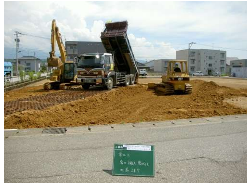
客土搬入・復元を進めている農地 (黒部2次地区:黒部市)
