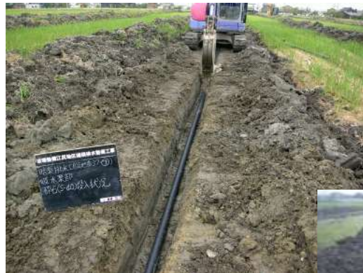
暗渠排水の施工により 汎用化される水田 (江尻地区:高岡市)
