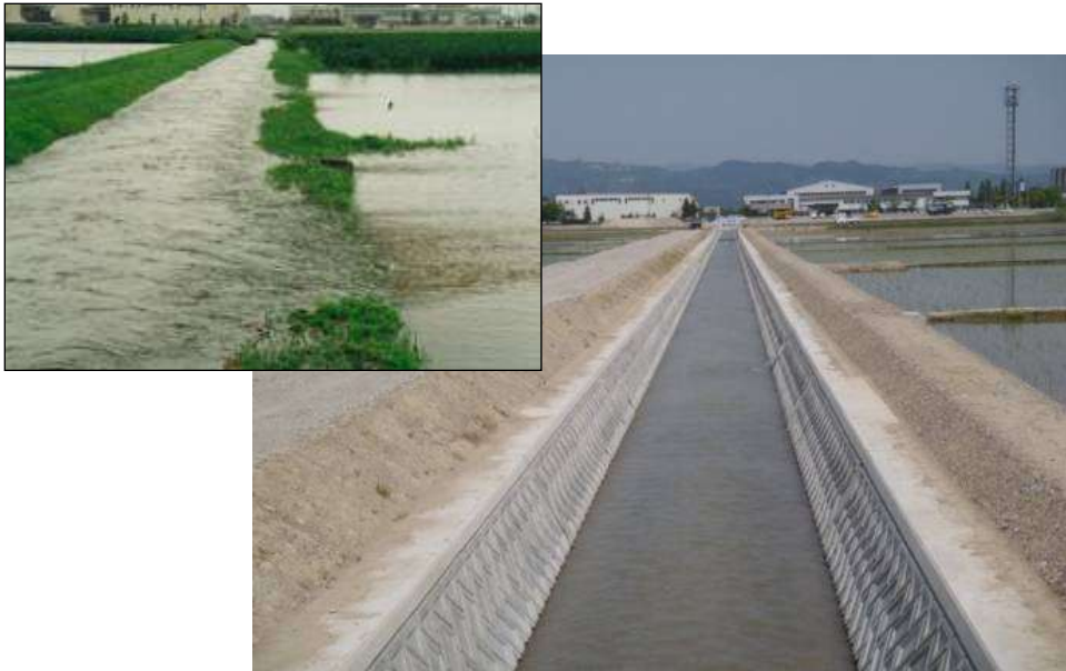
排水量増加に対応して整備した狐島用水路 (庄川左岸一期地区:砺波市)
