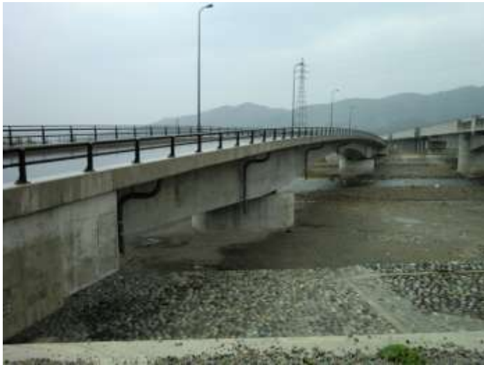
整備された基幹農道の橋梁(新川中部二期地区:朝日町)
