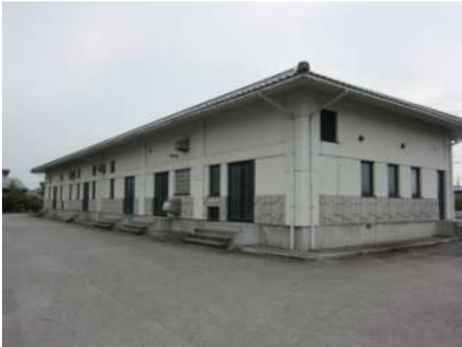
農業集落排水処理施設 (田家地区:黒部市)
