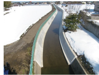
適切な整備による農業用水路の長寿命化 [富山市牛ヶ首用水]
