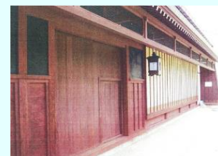
旧宮崎酒造の改修
