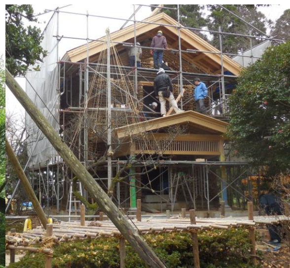
修復中の内山邸
