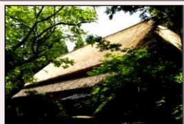
旧 中嶋家（砺波チューリップ 公園）の茅葺屋根の葺替え
