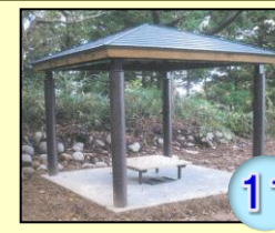
宮崎城址の東屋整備
