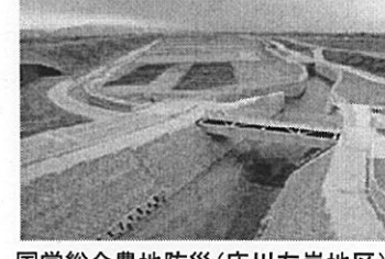
国営総合農地防災(庄川左岸地区) 庄川放水路(高岡市)
