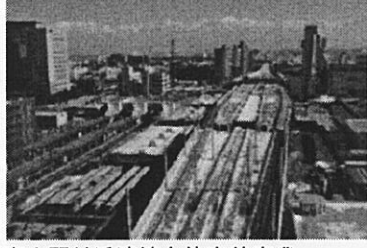
富山駅付近連続立体交差事業
