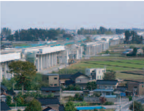
新黒部駅(仮称)高架橋(建設中)
