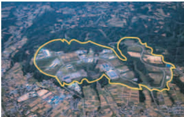
富山八尾中核工業団地
