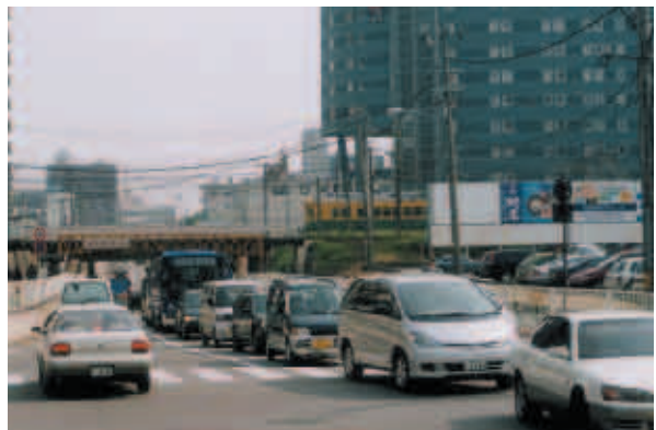
鉄道による市街地の南北分断 (交通渋滞、通行車両の高さ制限等)
