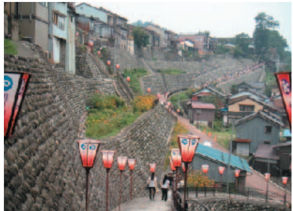
急傾斜地崩壊防止施設の整備(富山市八尾町)
